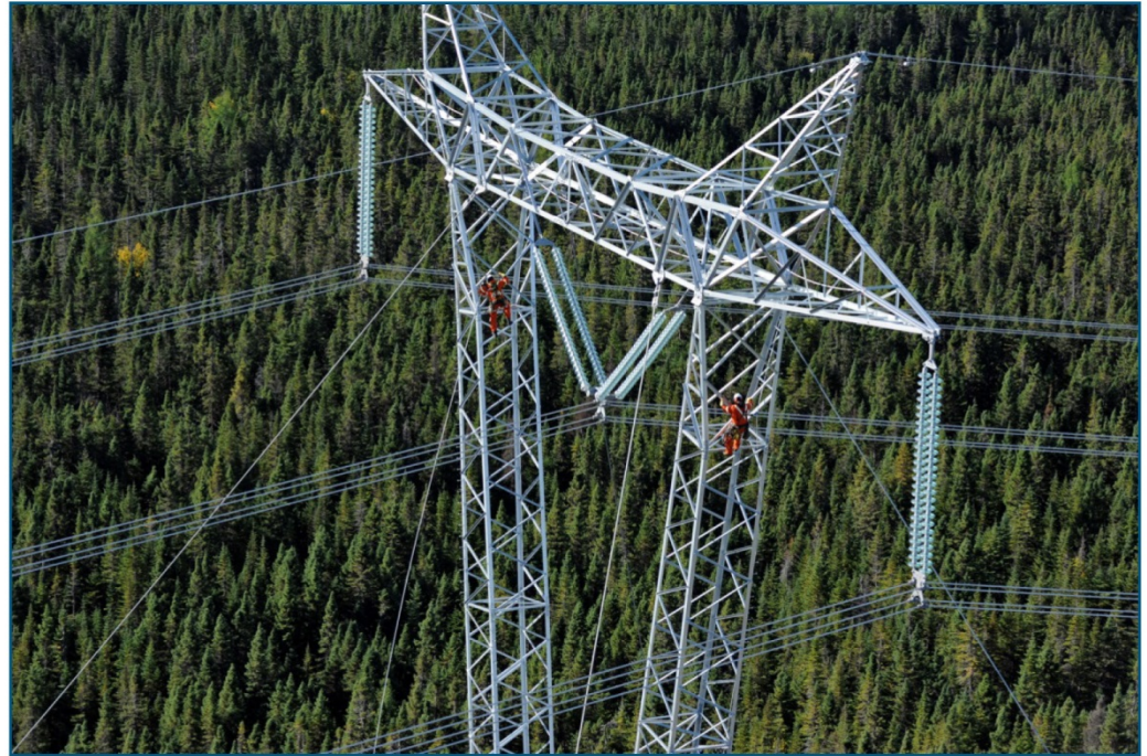
Inspection d'un pylône en V haubané de la nouvelle ligne de la Romaine-2-Arnaud
